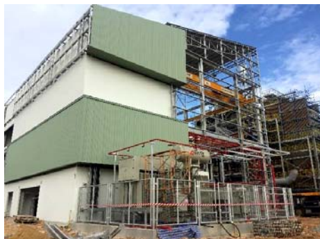
งานก่อสร้างอาคารและฐานรากเครื่องจักร TG
