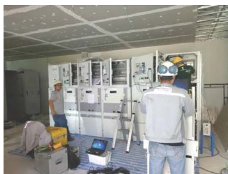
งานติดตั้งระบบไฟฟ้าในโรงงาน งานติดตั้ง Medium and Low voltage switch gear
