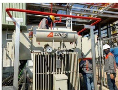
งานก่อสร้างฐานรากหม้อแปลงและติดตั้งหม้อแปลงไฟฟ้า (Export and Service Transformer)
