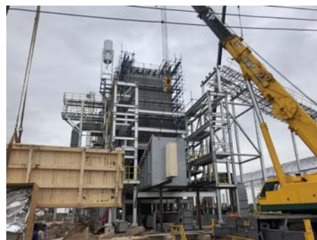
งานก่อสร้างฐานรากเครื่องจักรและติดตั้งเครื่องจักร Boiler
