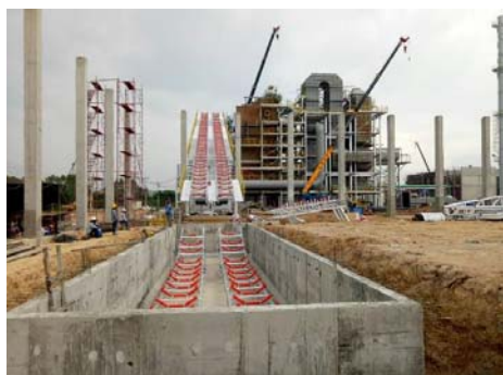
งานก่อสร้างและติดตั้งเครื่องจักร ระบบลำเลียงเชื้อเพลิง (Fuel handling system)
