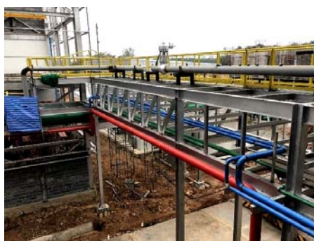
งานระบบท่อเชื่อมต่อระหว่าง Unit (Interconnecting pipe)
