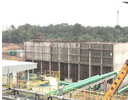
งานก่อสร้างและติดตั้งอุปกรณ์ Cooling Tower
