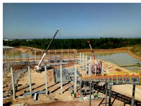
งานก่อสร้างและติดตั้งเครื่องจักร ระบบลำเลียงเชื้อเพลิง (Fuel handling system)
