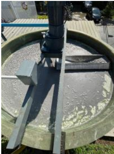
งานป้อนน้ำเสียเข้าบ่อดักไขมัน
